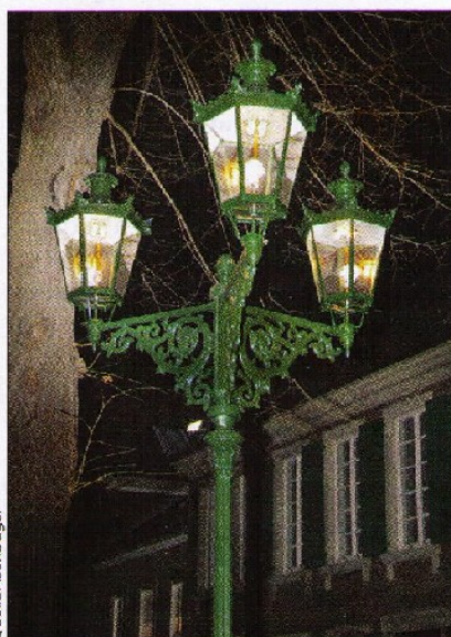
Bild 1: Historische Leuchte, umgerüstet auf LED – eine Innovation aus dem Handwerk
